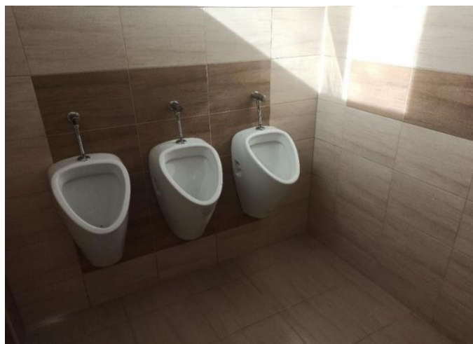
Obr. 4 – Oprava pánského WC v přízemí hlavní budovy školy v prosinci 2023
